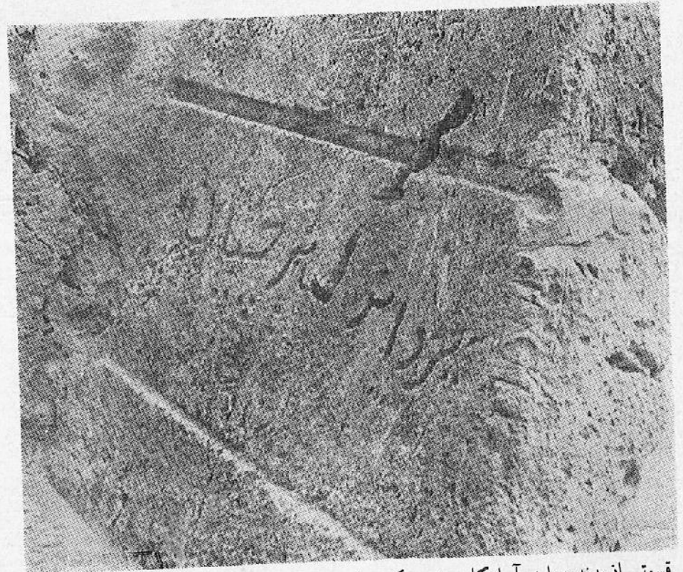
قسمتی از بدنه دهلیز آرامگاه جنوبی که در اثر تخریب جدار در حال سقوط است. بر روی این بدنه کیفیت حجاری قیرهای کثوئی بخوبی نمایان است یعنی شیارهای طویل بعمق و پهنای ۳ سانتیمتر که بمنظور جای گیری زائده لبه تابوتها بوجود آمده است
