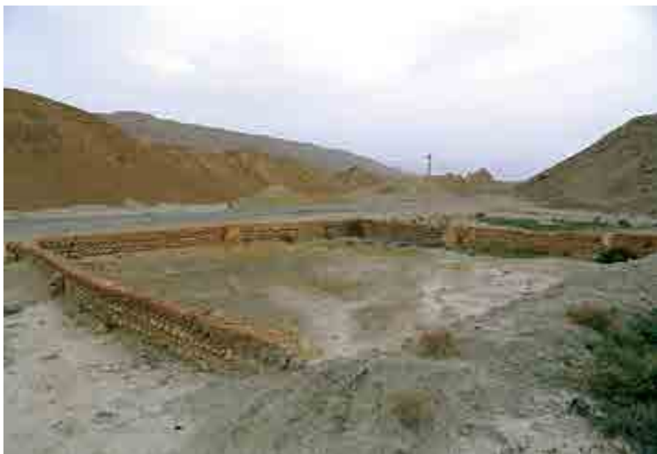
۸۶. سازه آبی ذخیره آب، چشمه فاریاب چاه ورز، بیرم.
